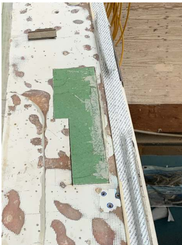
Een rotte plek in het dek wordt zo hersteld
