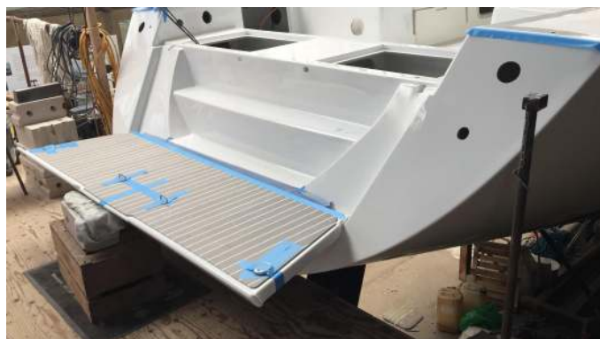
Het pvc is geplakt op het zwemplateau. Even genieten van de ruimte en het beslag wordt gemonteerd.
